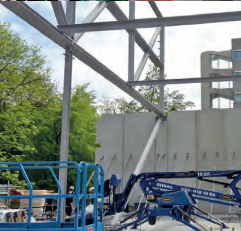
De spanten van de sporthal.
