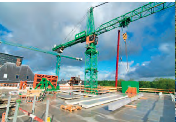
Uitzicht op het dak.
